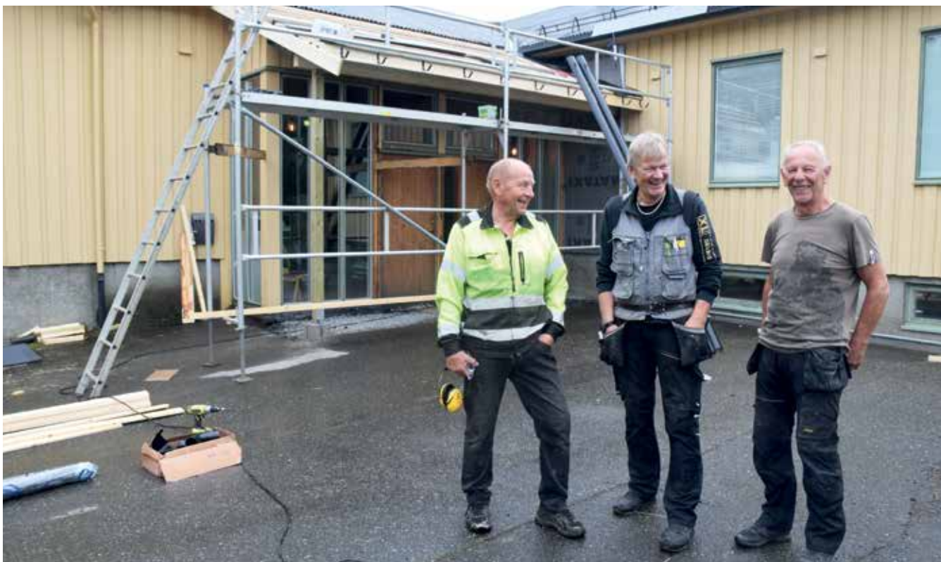
Ingar Gullbrekken, Per Birger Kulseth og Åge Kjeldstad har lagt ned et stort arbeid for å få til et nytt inngangsparti til menighetshuset. Foto: Svein Hilmo
